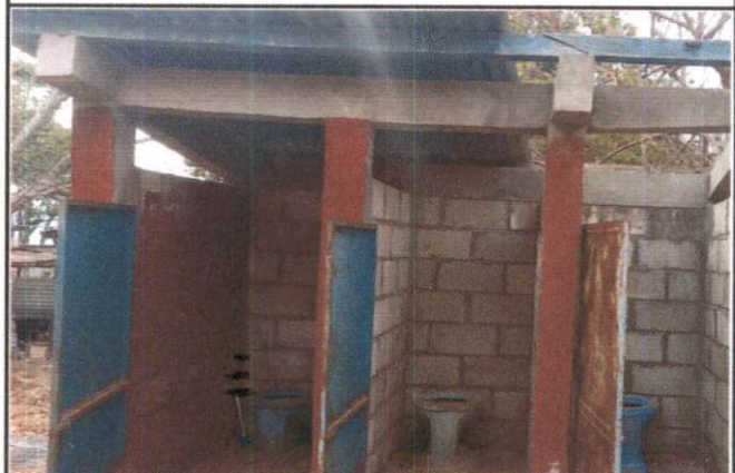
Foto 4: MEJORAMIENTO DE SERVICIOS SANITARIOS Y SUS ACCESORIOS
