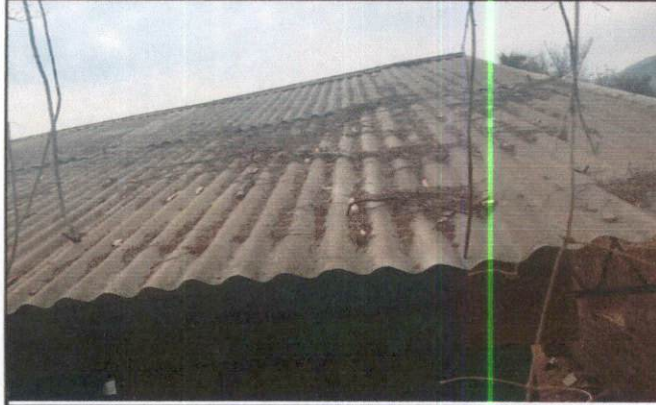
Foto 1: MEJORAMIENTO DE ESTRUCTURA DE TECHO TIPO PORTICO
