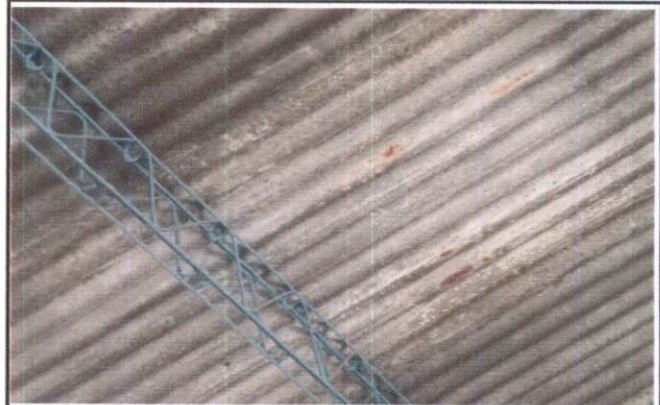
Foto 2: MEJORAMIENTO DE ESTRUCTURA DE TECHO TIPO PORTICO
